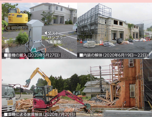
図2 建物G(地上2階木造アパート)
