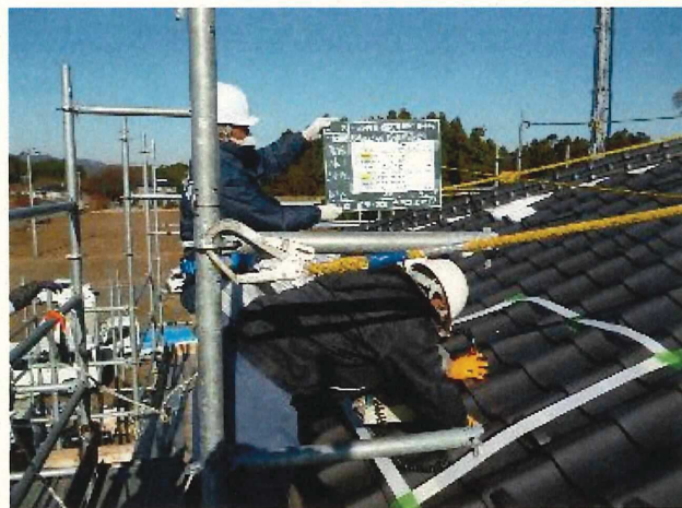
屋根の確認調査の様子
