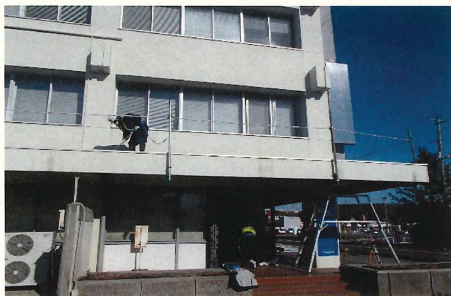
建物除染の様子
