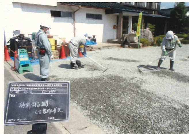
砕石の敷き直しの様子
