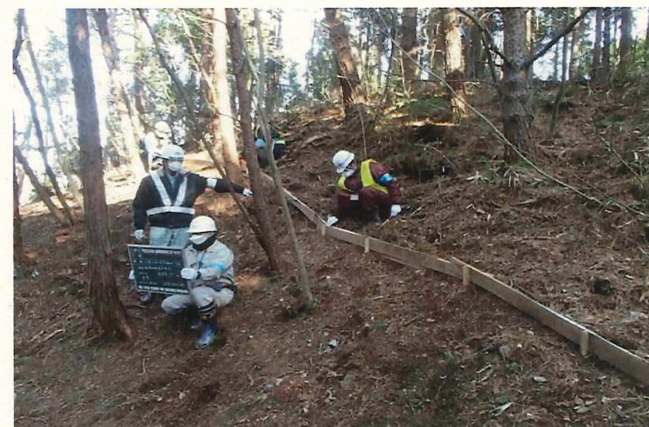
再拡散防止策設置の様子
