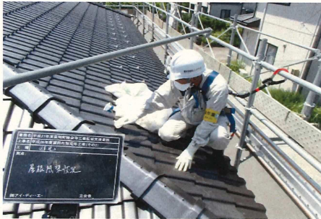
屋根雨樋除染の様子
