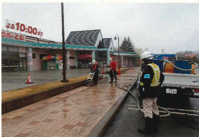
歩道除染の様子
