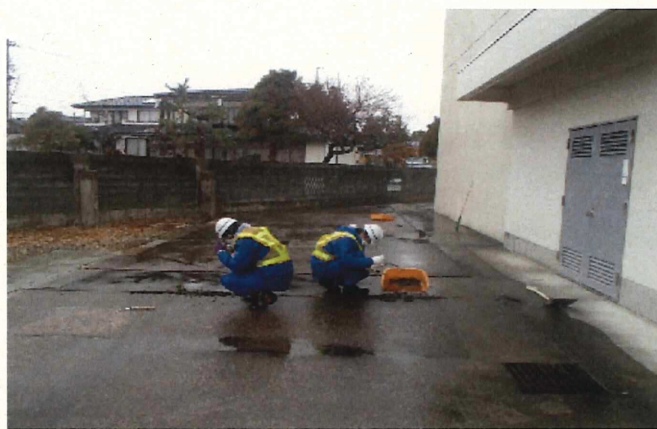
コンクリート隙間の堆積物除去の様子
