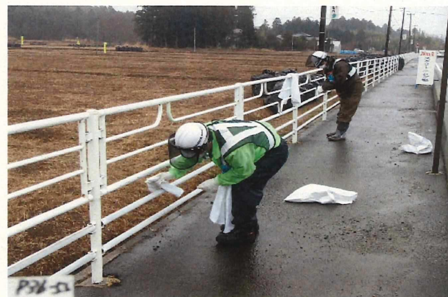
ガードパイプ拭き取りの様子
