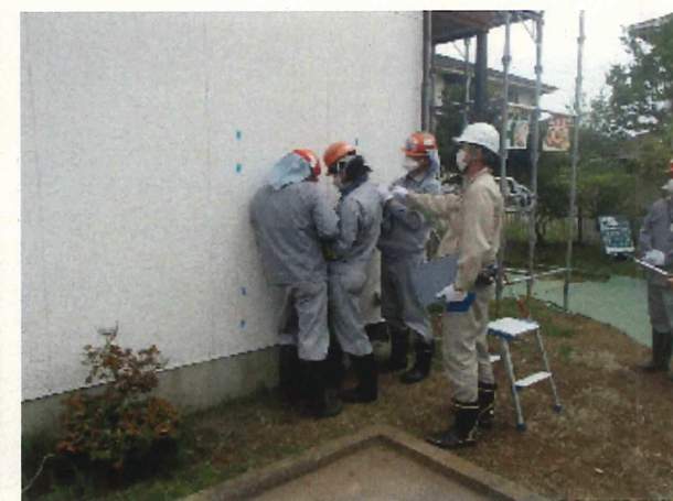
壁の確認調査の様子
