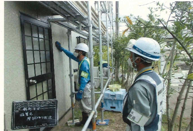
壁面除染の様子
