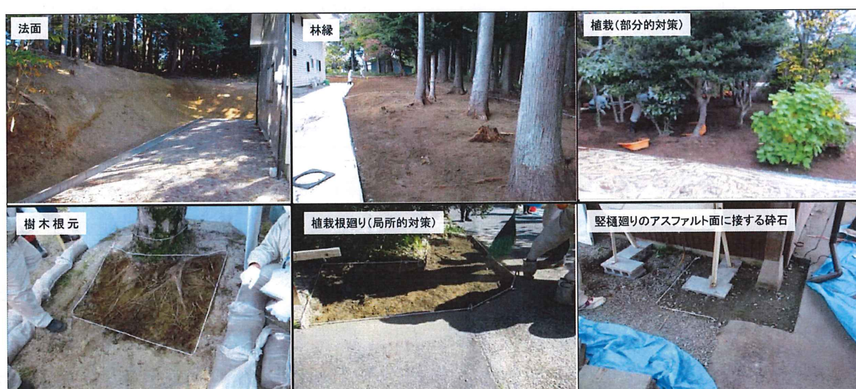
図-12 フォローアップ除染対象箇所の例
