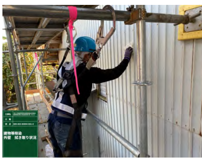
壁面除染の様子
