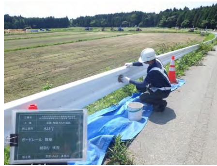
ガードレール除染の様子
