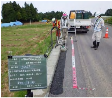
高圧水洗浄の様子
