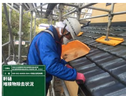
屋根・雨樋除染の様子
