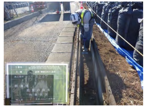
道路側溝除染の様子
