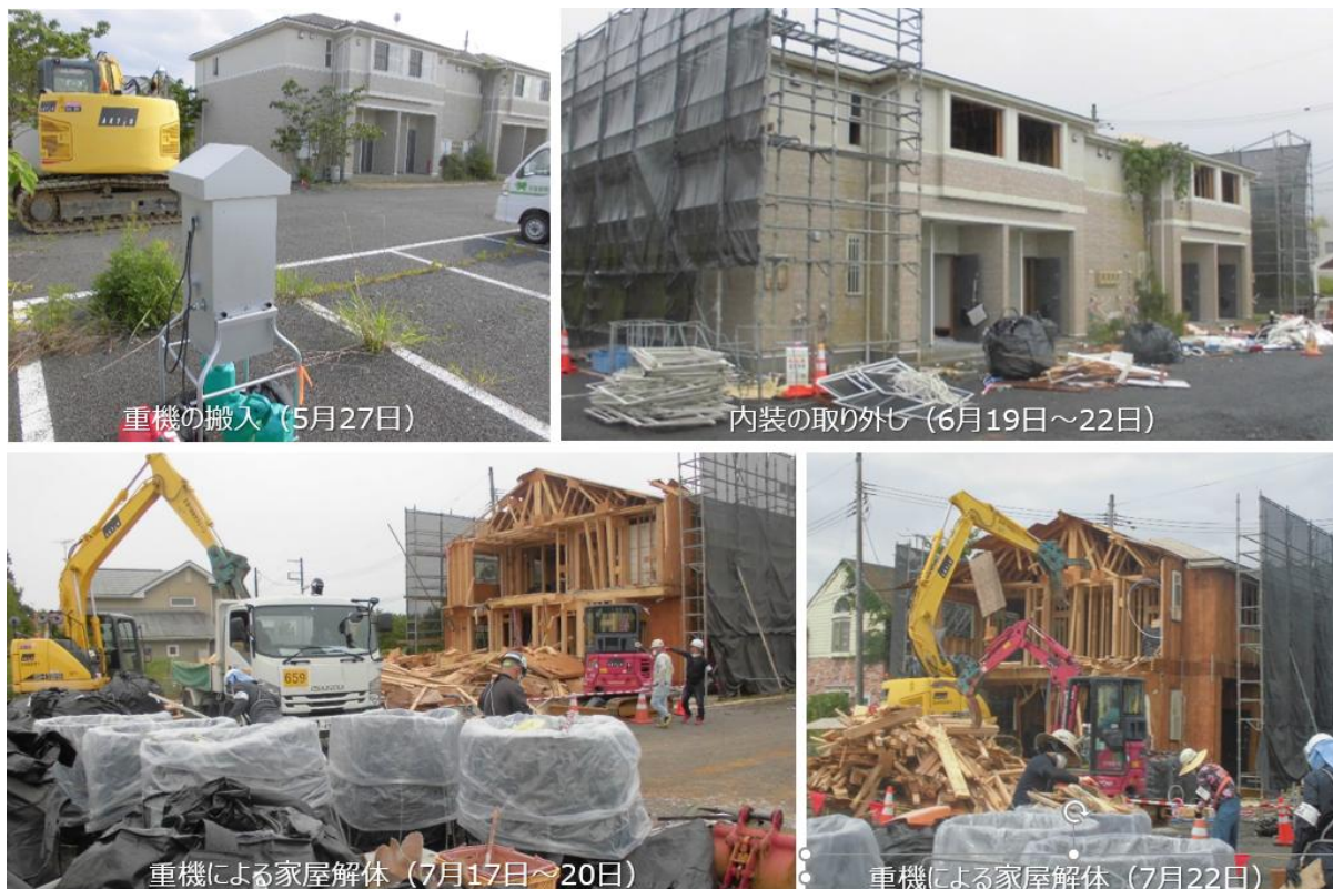
図 3 解体作業と屋外ダストの捕集状況(2020 年 5 月～8 月)
