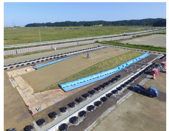
試験盛土のようす
