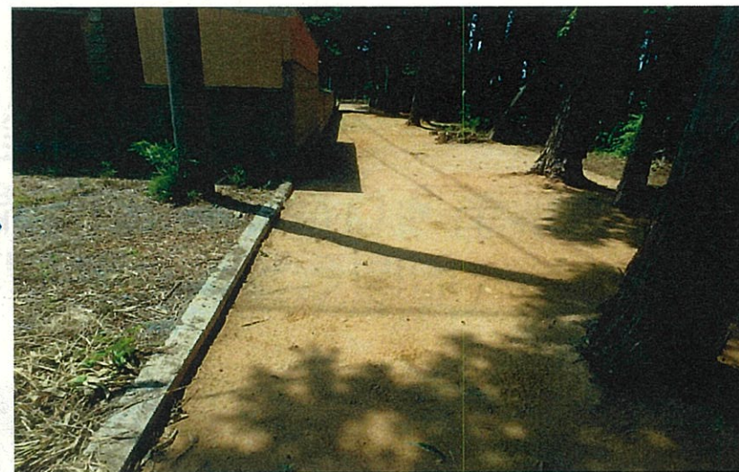
5m幅、5cm厚で表土剥ぎ取り後客土
