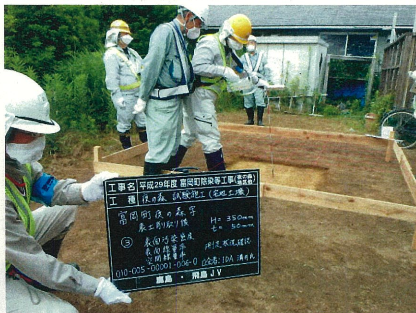
（試験施工実施状況）
